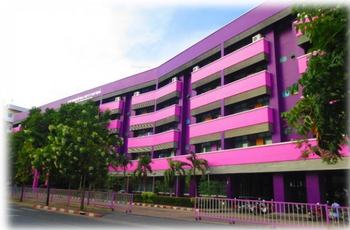
อาคารหอพัก คณะพยาบาลศาสตร์
